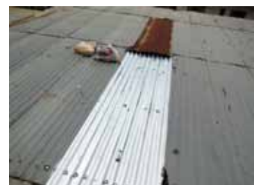
Remplacement de quelques tôles
