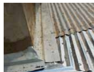
Remplacement de quelques tôles
