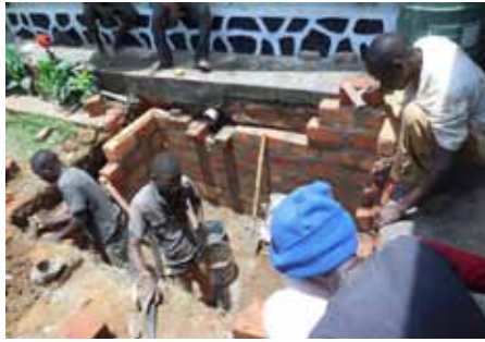
Construction d'une citerne de 25 M 3
