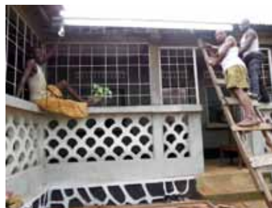
Pose des gouttières
