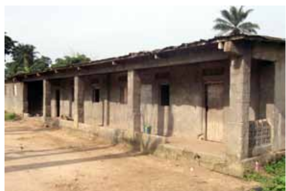
Dortoir à transformer en 4 classes à Nsanda
