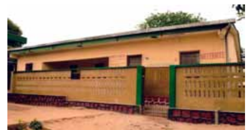
Centre de santé après travaux
